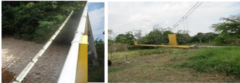
FOTOGRAFÍAS 1: VIADUCTOS RED DE ALCANTARILLADO SOBRE QUEBRADA LA PAVA
