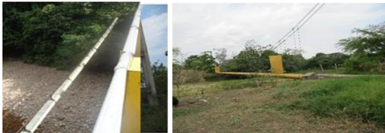
FOTOGRAFIAS 1: VIADUCTOS RED DE ALCANTARILLADO SOBRE QUEBRADA LA PAVA
