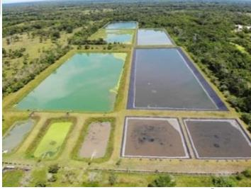
Se cuenta con un sistema de tratamiento de agua residual median 2 trenes de lagunas con tratamiento primario y secundario con microorganismos que realiza una digestión de material orgánico y así darle un tratamiento de descontaminación
